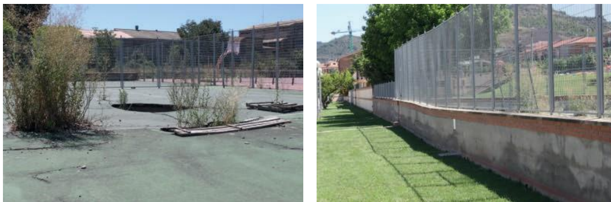
Figura A4-10. Enfonsaments en unes pistes esportives a Ponts (Noguera) produïts per la presència de guixos. Font: ICGC.
