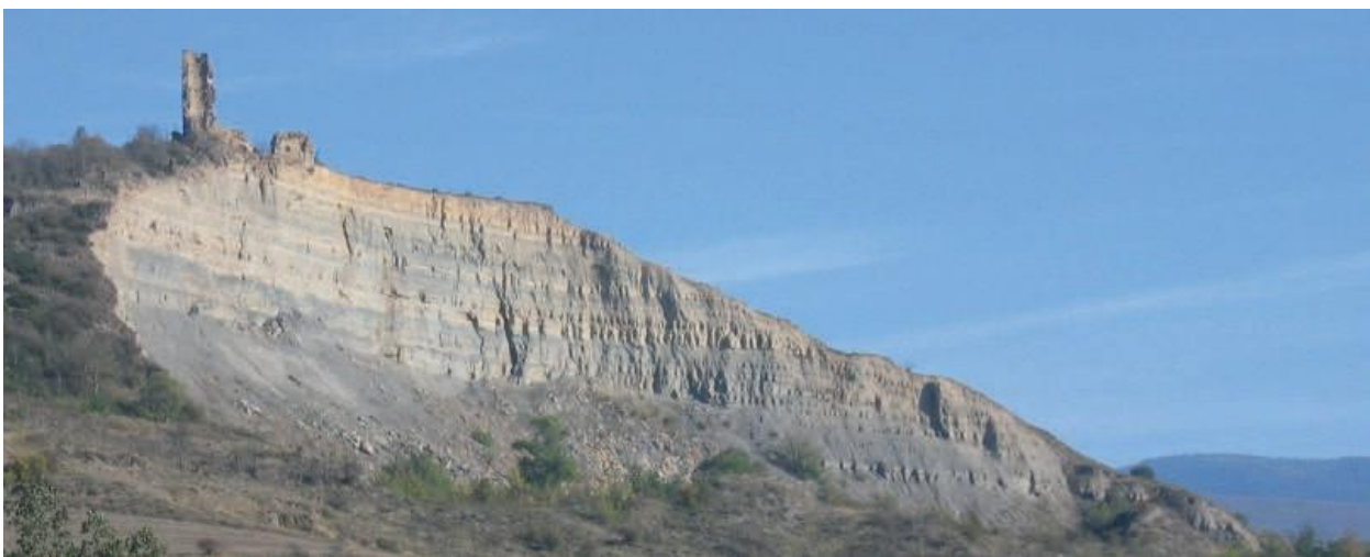
Figura A2-4. Escarpament i vista parcial del cos del lliscament rotacional de Puigcerçós de mida destructiva M5 que va esdevenir el 13 de gener de 1881 i que va comportar l'abandonament de la població situada al turó. Font: ICGC.
