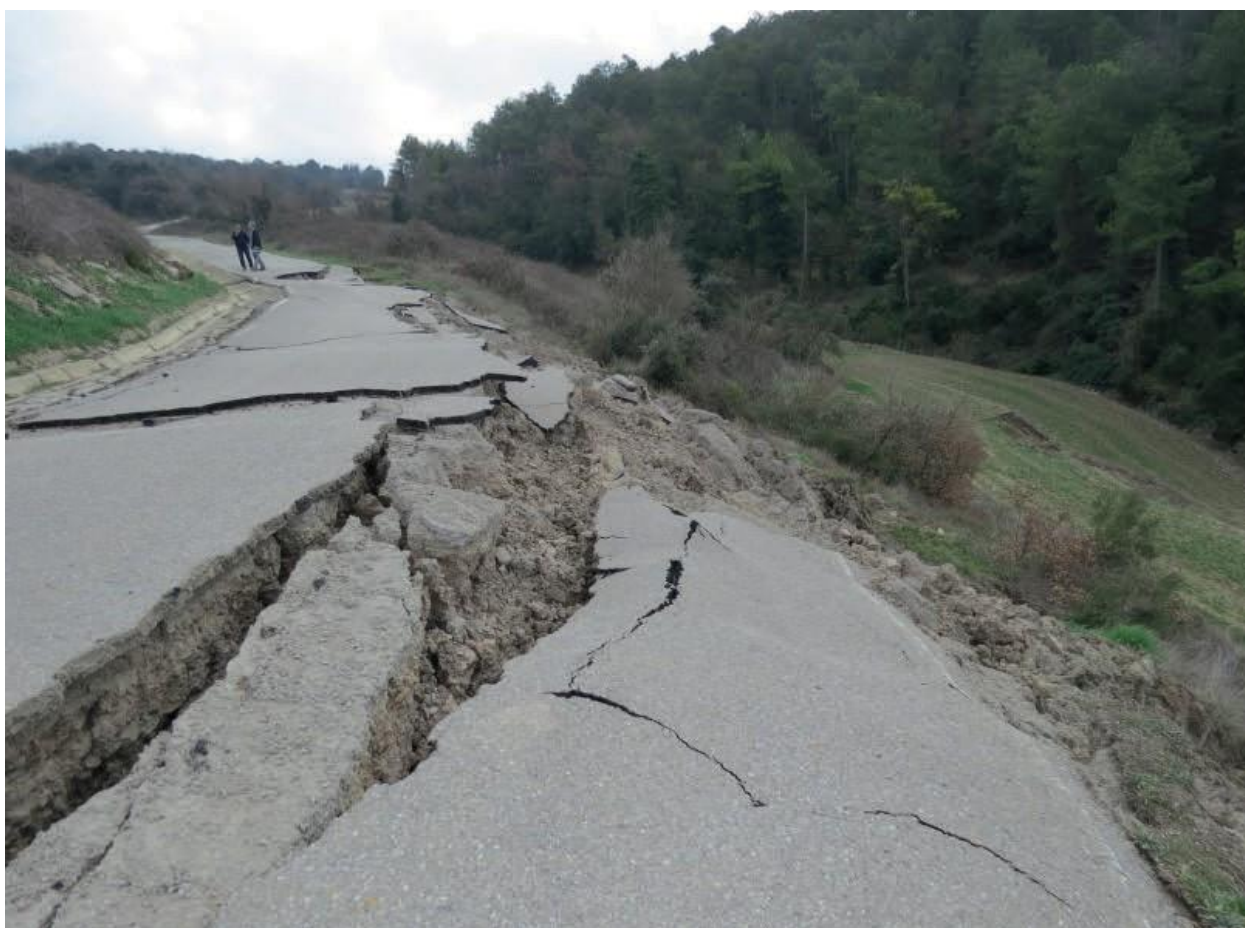
Figura A2-7. Lliscament superficial que va afectar el Camí de les Basses, a la Molsosa, el 23 de gener de 2020. Font: ICGC.
