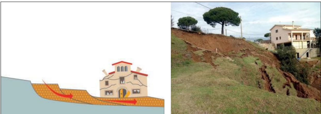
Figura 3. Tall esquemàtic representatiu d'un lliscament del terreny. Fotografia: Capçalera d'un lliscament rotacional ocorregut al Veïnat de Can Ram de Sant Pere de Vilamajor, el 24 de gener de 2020. Font: ICGC.
