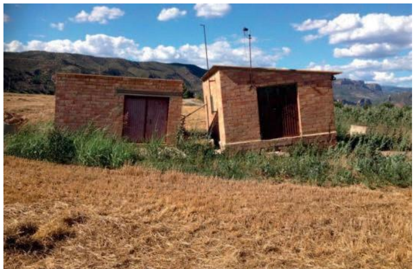
Figura A4-5. Enfonsament en una cobertora de terreny granular a Gerb (Noguera). Font: ICGC.
