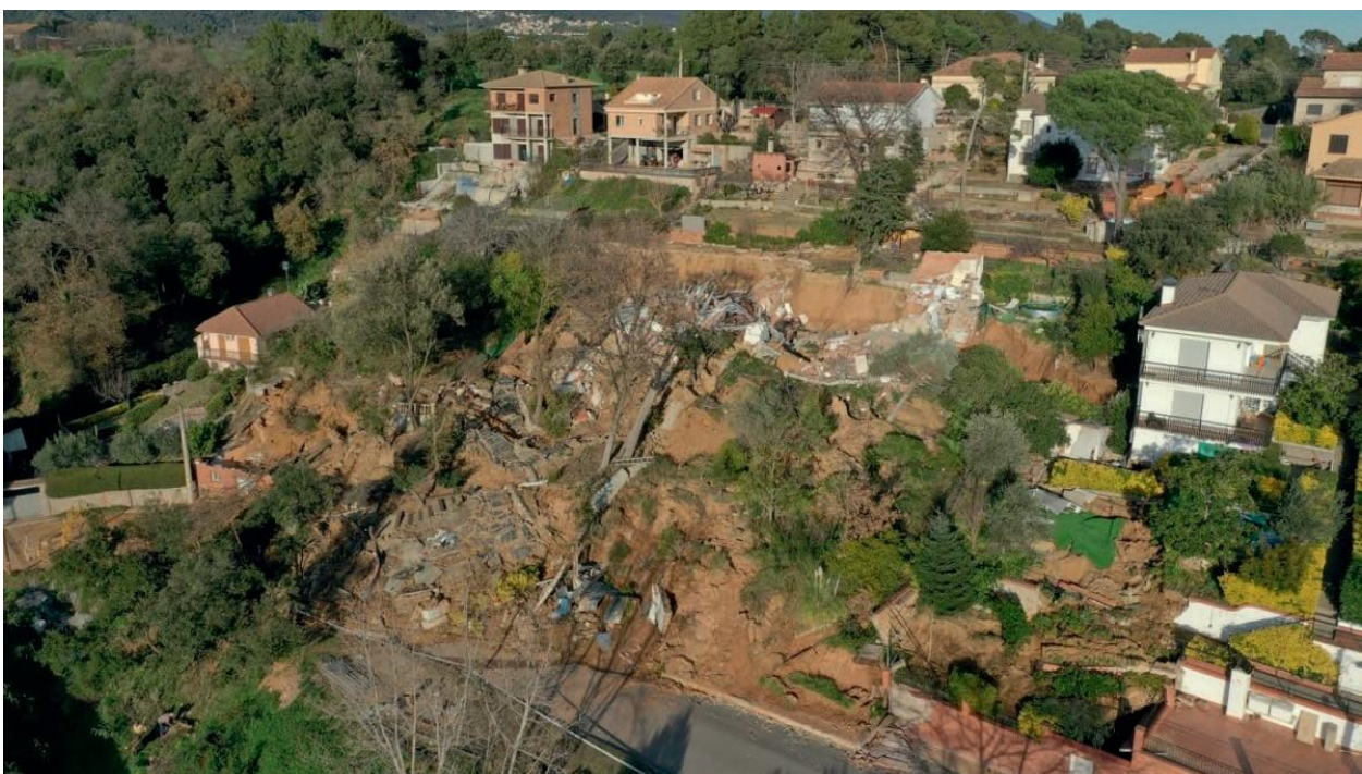
Figura A2-5. Vista aèria del lliscament de Ca l'Esmandia durant el temporal Gloria (gener de 2020), que va provocar l'esfondrament de 3 cases. Fotografia publicada a Twitter per Afectats Temporal Gloria Cànoves (@AfectatsCanoves).
